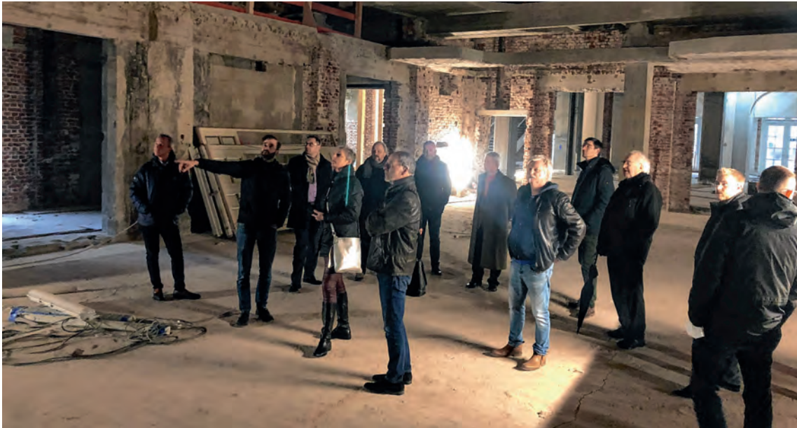
DG Aachen bei einem Besuch der Baustelle des Neuen Kurhauses. Foto: Andree Brüning
